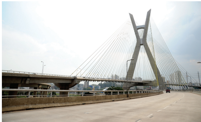
Figura 17.2: Ponte Estaiada na cidade de São Paulo. Foi construída tendo como base científica, entre outros, os princípios que regem a Estática.
